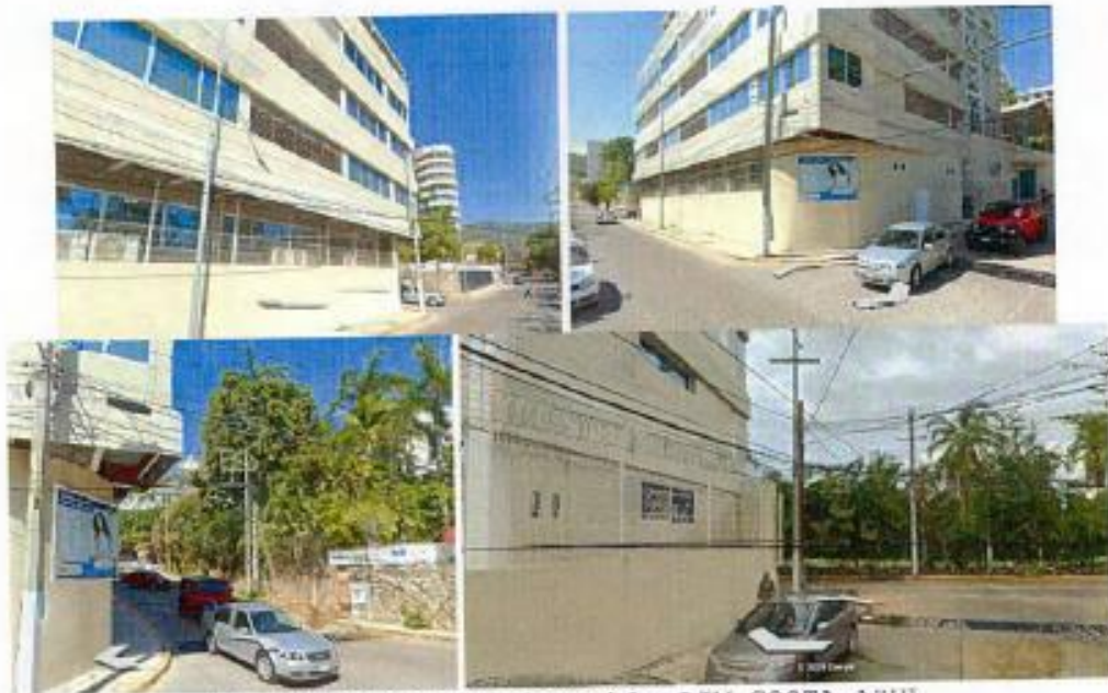
Instalaciones del inmueble LIM COSTA AZUL
